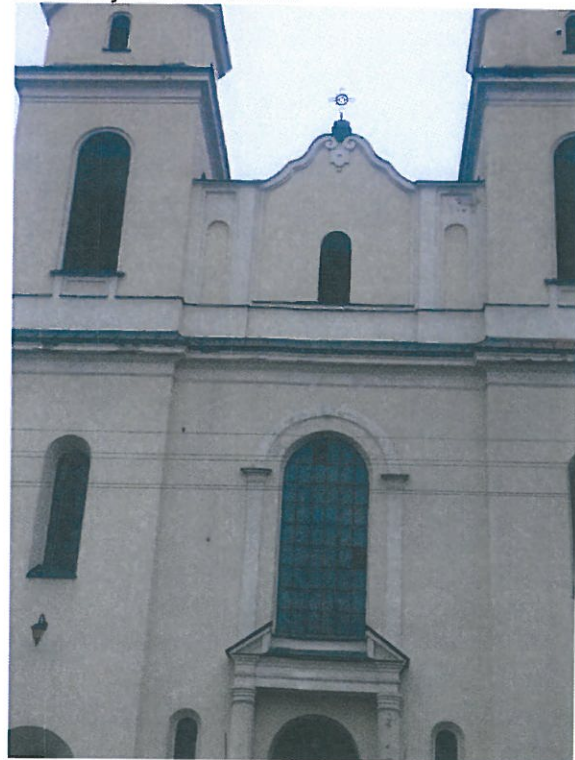
Elewacja południowa miejscowe ubytki i uszkodzenie gzymsów
