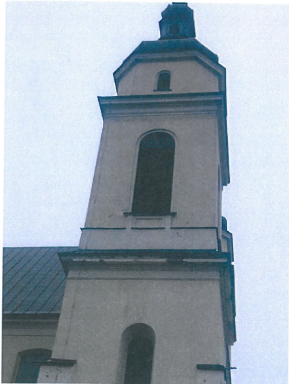
Elewacja zachodnia - miejscowe uszkodzenia i ubytki tynku na gzymsach Elewacja południowa – miejscowe
